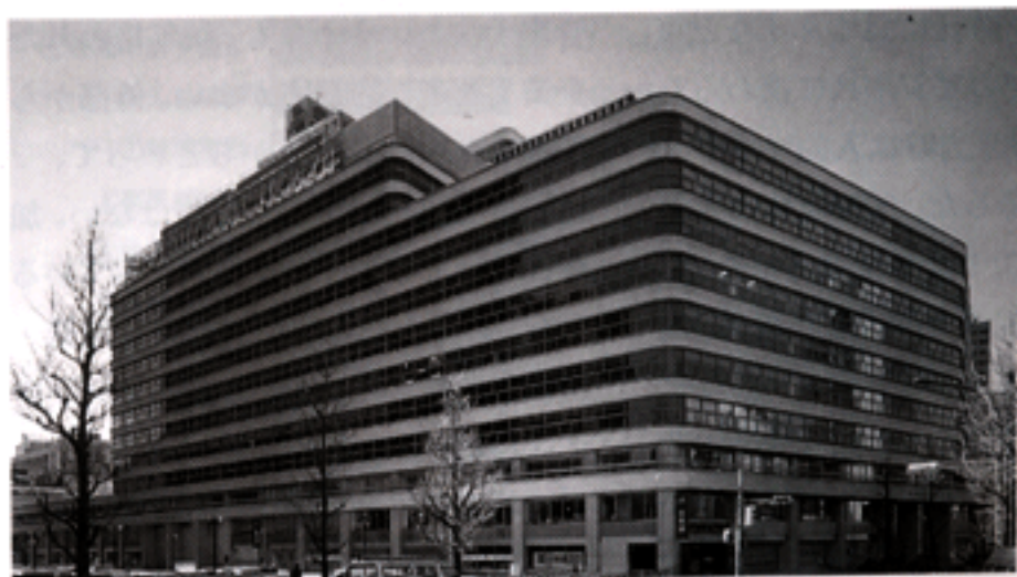
ケソフトエンタープライズ本社が入居する東京・大手町の日本ビル
